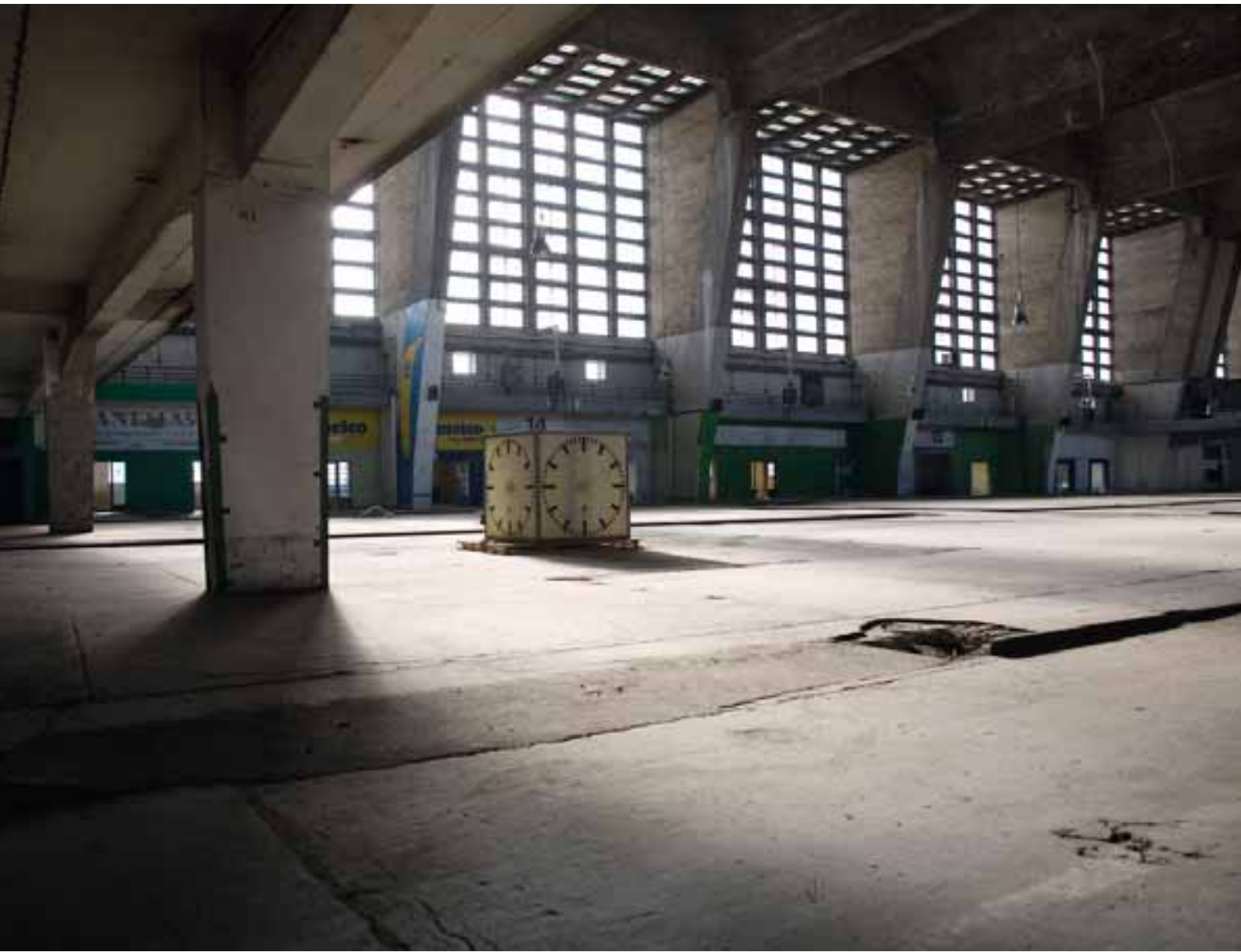
Vue intérieure de l'ancienne Grossmarkthalle , bâtiment classé (février 2008). Conçue par Martin Elsaesser, la Grossmarkthalle était le plus grand espace couvert à structure auto-portante en béton armé du monde lors de son achèvement en 1928.
