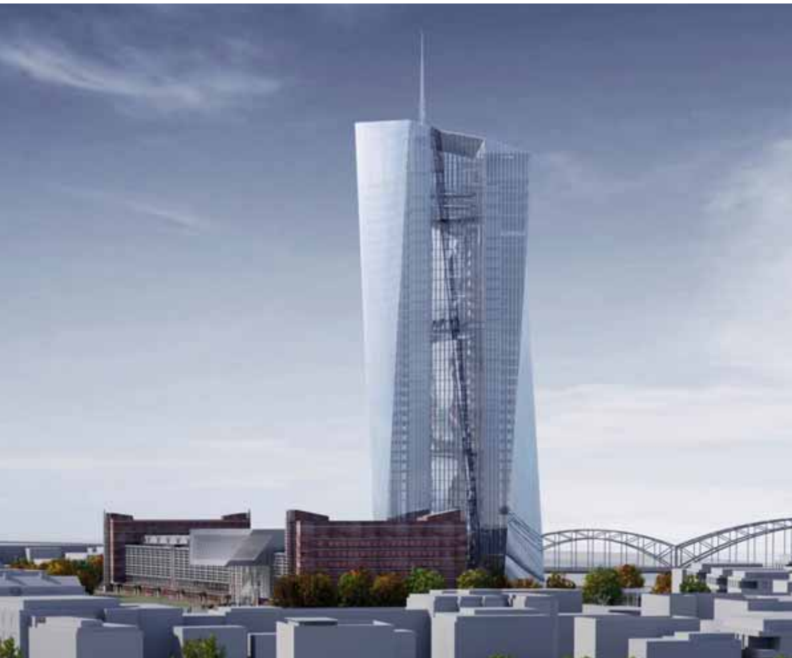
Le nouveau siège de la BCE, conçu par COOP HIMMELB(L)AU, doit être achevé en 2013. L'ensemble comprendra trois grands corps de bâtiment, à savoir le gratte-ciel, l'ancienne Grossmarkthalle et le bâtiment d'entrée.
