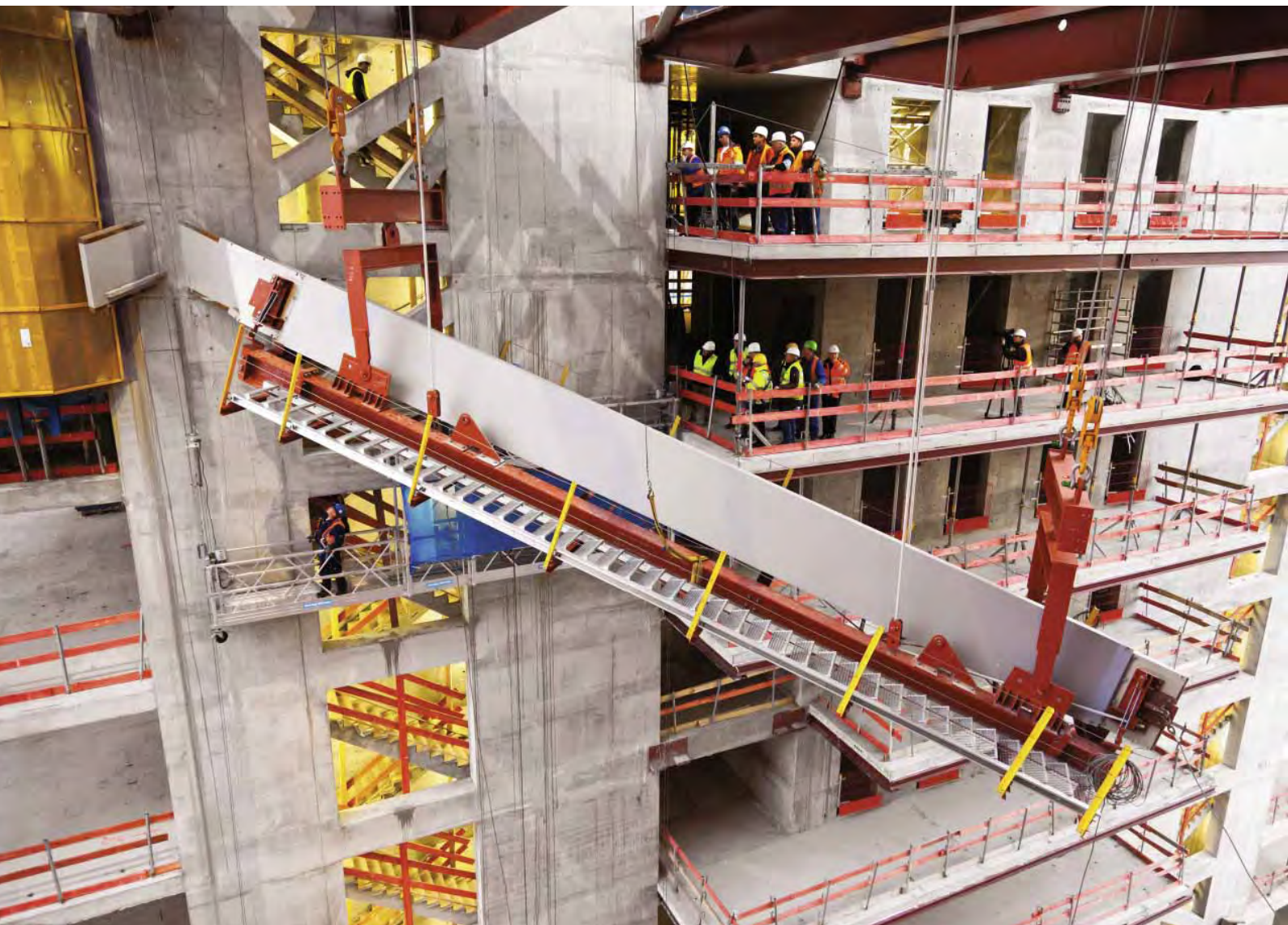
In november 2011 zijn in het atrium, tussen de twee kantoorstorens, de eerste van in totaal veertien draagbalken geplaatst. Met de overstapplatformen fungeren deze balken als stutten voor de twee kantoorstorens.
